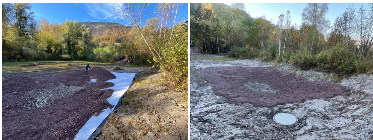
Abb. 2/3: Einbau Überdeckung (links) & Regulierschacht mit Kugelhahn (rechts) / Gewässer Nr. 8
