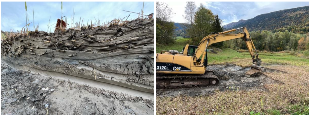
Abb. 6/7: Rhizom- und Pressschlamm-Schicht (links) & Aushub Verlandung (rechts) / Gewässer Nr. 2
