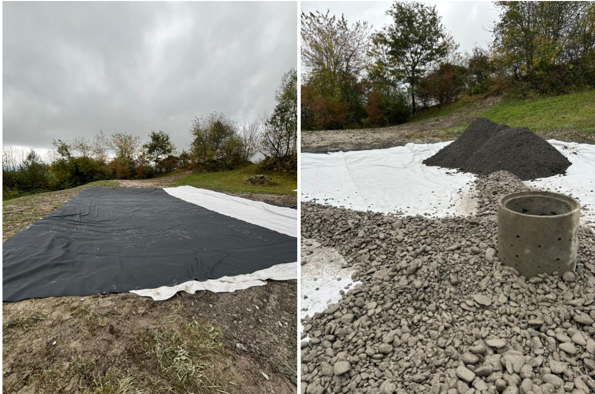
Abb. 8/9: Einbau Abdichtung (links) & Kontrollschacht mit Sickergeröll (rechts) / Gewässer Nr. 2
