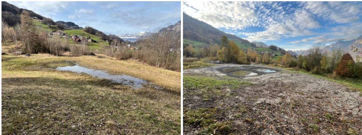
Abb. 10/11: Situation vor (links) & nach Abschluss der Bauarbeiten (rechts) / Gewässer Nr. 2
