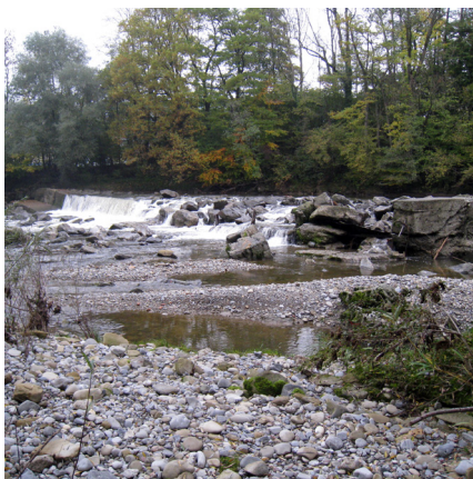
Das zerfallene Wehr bei Grafenau wird abgebrochen und wenig oberhalb durch ein Kleinwasserkraftwerk ersetzt. (Foto: Pro Natura St. Gallen-Appenzell)
