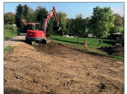
Gestaltung befahrbarer Flächen nach Entsorgung von Altlasten sowie von Fichten- und Brombeerbewuchs.
